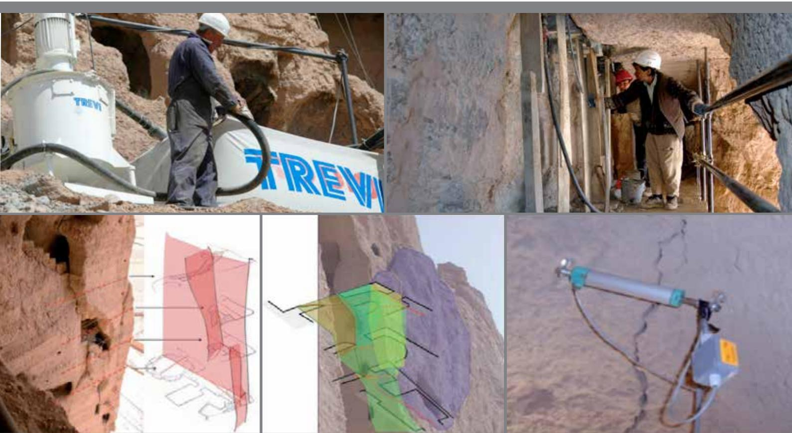
Il monitoraggio delle fessure denotava un costante allargamento delle stesse e il blocco roccioso avrebbe potuto non resistere ad un ulteriore ciclo gelivo nell'inverno imminente. Il crollo avrebbe potuto coinvolgere una gran parte della zona superiore destra della nicchia, distruggendo quasi completamente la fisionomia restante del monumento.
