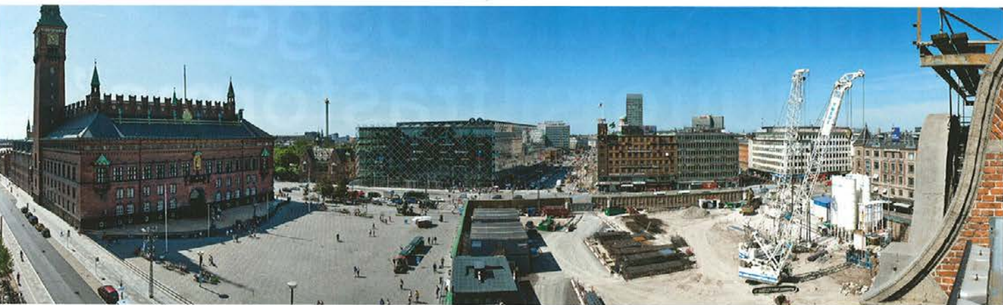
Panoramica - Cantiere Trevi - Copenhagen
